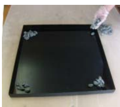
②四隅の水抜き穴に小石を置く
